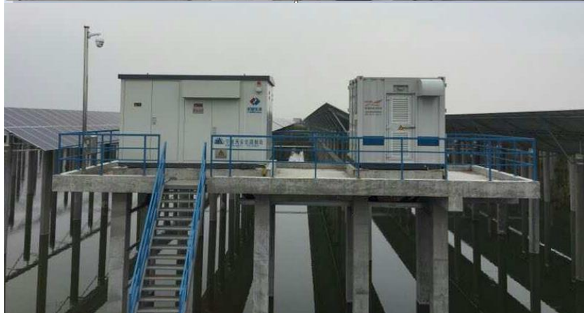
Проект солнечной электростанции в Китае на 150 MW, использовались 74 инвертора на 1.26MW +4 инвертора на 630KW (2018)
