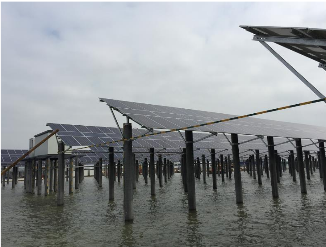
Проект солнечной электростанции в Китае на 150 MW, использовались 74 инвертора на 1.26MW +4 инвертора на 630KW (2018)
